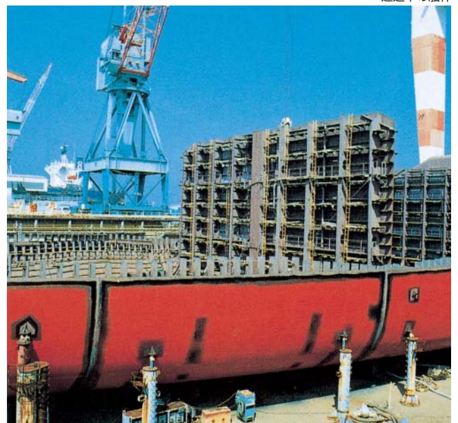
建造中の船体
