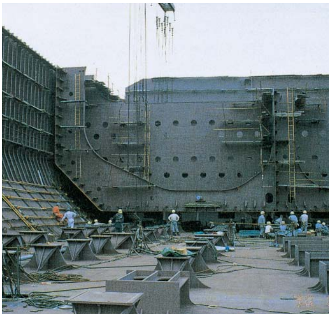
建造中の船体
